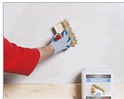
1. Gruntowanie środkiem STEGU GRUNT Apply surface primer STEGU GRUNT
