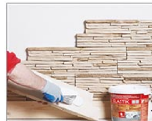
4. Klejenie klejem STEGU ELASTIK Add on adhesive like STEGU ELASTIK
